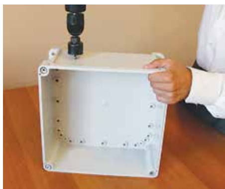
1. Просверлите отверстия
