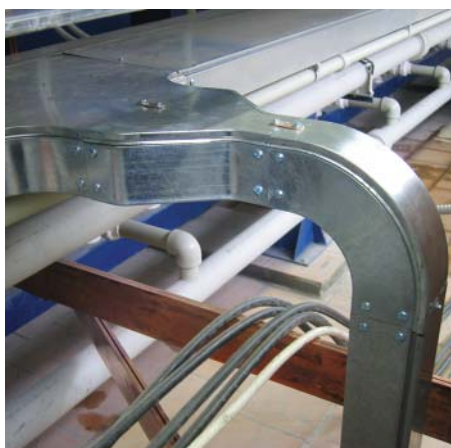
Ответвление лотка с использованием перехода по ширине
