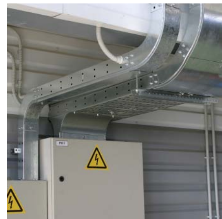
Использование углов и крепежных элементов для подвода кабельной трассы к электрошлиту
