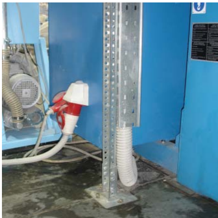
Использование крепления SSM как напольной стойки
