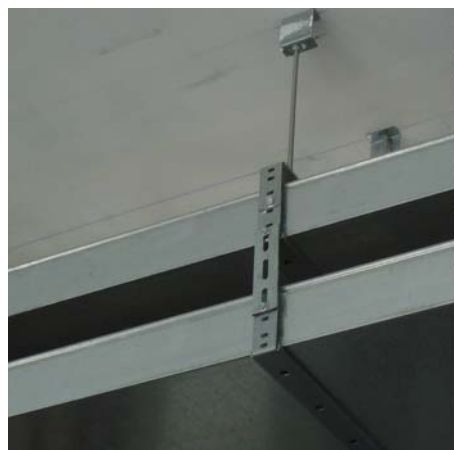
Многоуровневый подвес с использованием скоб STP/STS
