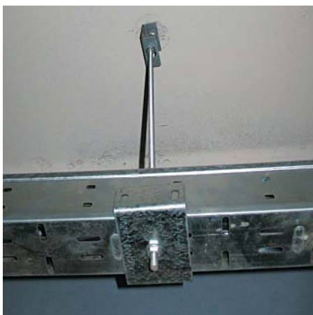
Монтаж на одну шпильку
