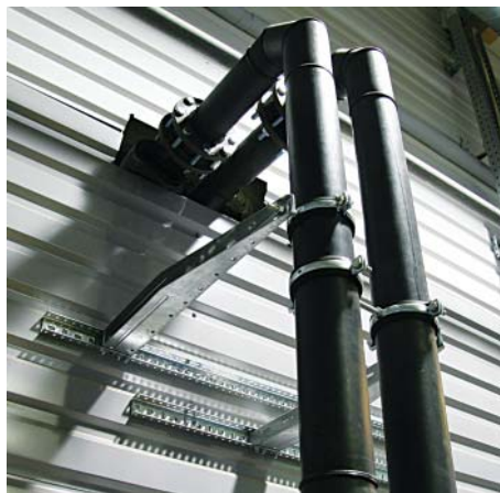
Подвес коммуникаций с помощью консолей
