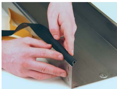
Монтаж ленты толщиной 2 мм на кромку лотка
