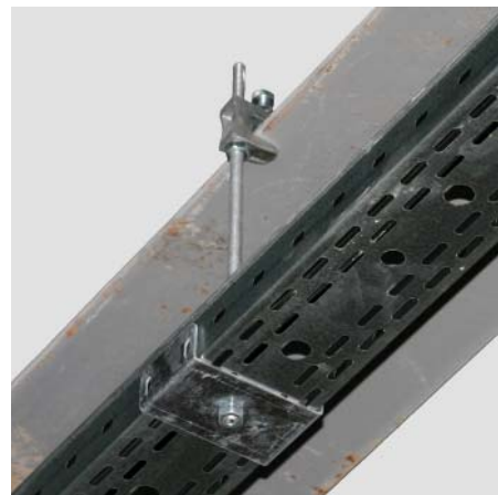
Подвес на шпильку и струбцину к швеллеру
