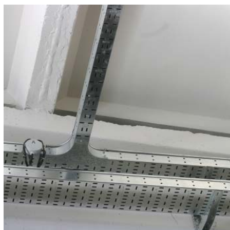
Установка коробки на боковину лотка
