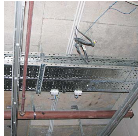
Многоярусный монтаж с использованием профиля и шпилек
