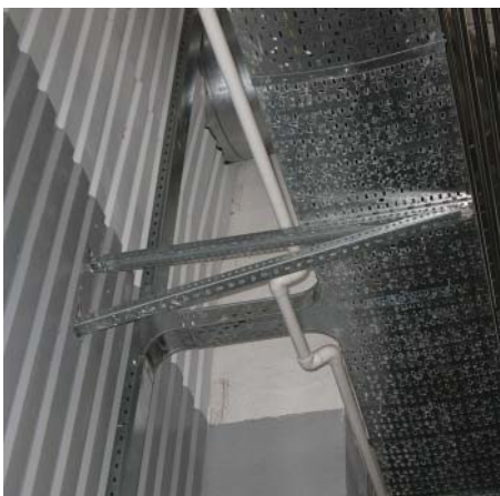
Использование профиля как дополнительного упора при больших нагрузках
