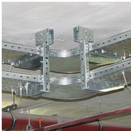
Многоуровневая прокладка кабельной трассы
