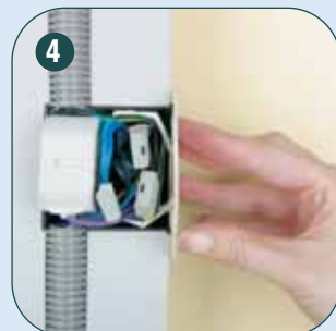
4 Встраивание актуатора в установочную коробку с крышкой или монтажную коробку выключателя
