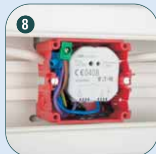
8 Установка актуатора в коробке кабельного канала
