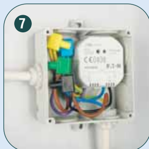
7 Установка актуатора во влагозащищенной коробке
