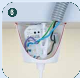
6 Установка актуатора в коробке светильника
