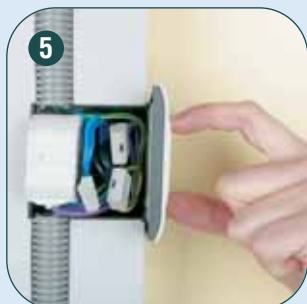
5 Установка актуатора в коробку выключателя в комбинации с радиовыключателем
